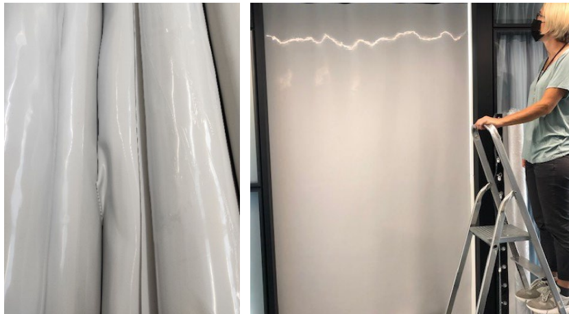
Fig 7. Zugabe, sowie Einbau des NoiseBlockers von Création Baumann.
