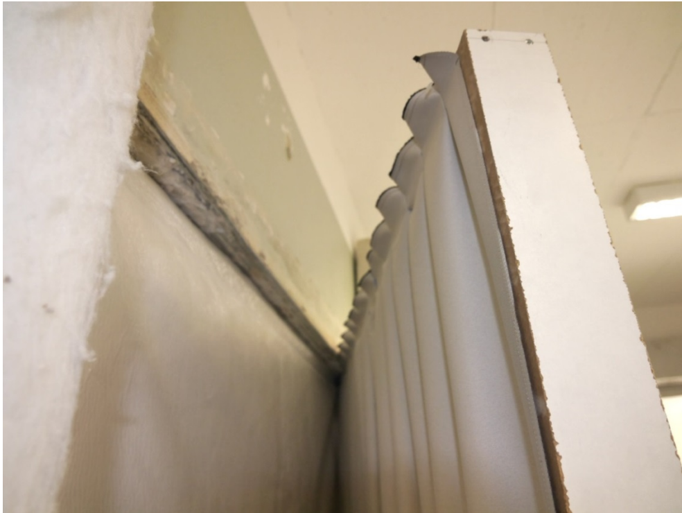
Abbildung B.3. Exemplarische Abbildung eines Aufbaus mit einer Lage Molton/Folie im Fensterprüfstand (Prüfaufbau geöffnet)
